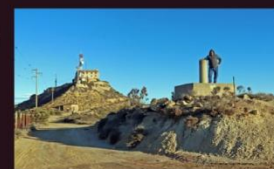
La ermita de San Caprasio a 834 metros de altitud y el vértice geodésico de referencia que ha servido para elaborar el actual sondeo.
